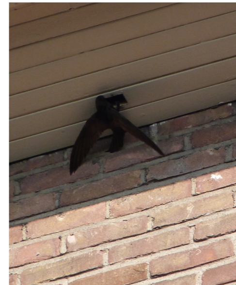
Gierzwaluwsteen weggewerkt in dakrand
