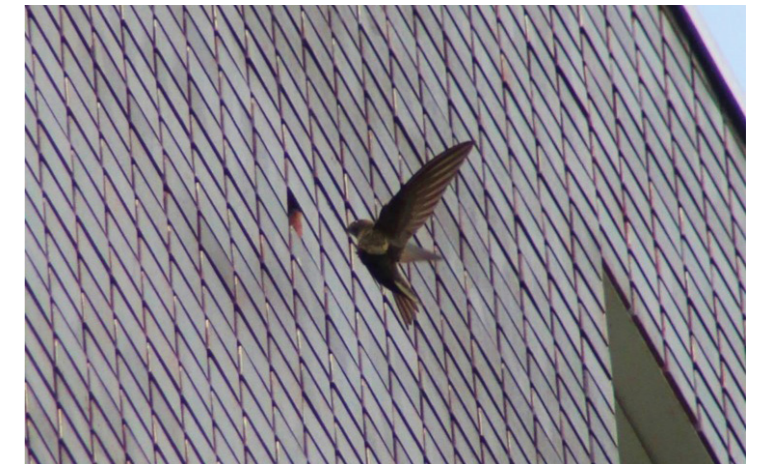
Gierzwaluwsteen weggewerkt in gevel
